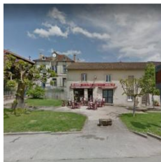
Auberge Avant Travaux
